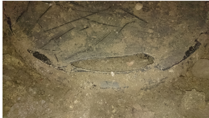
Trasigt brunnslöck troligen förstört i samband med frisättning av brunnen
