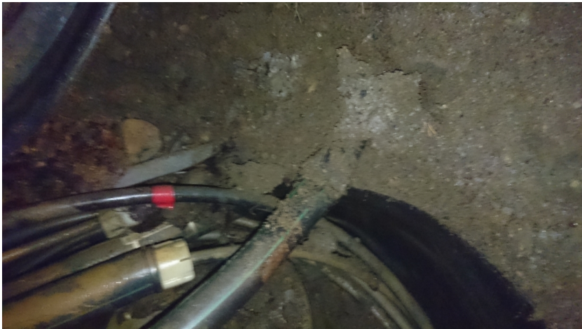
Skadad kanalisation beroende på Att den lagts ovanpå brunnen och inte dragits in i brunne från sidan.
